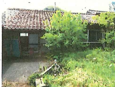
浴室棟及び倉庫・全 景
