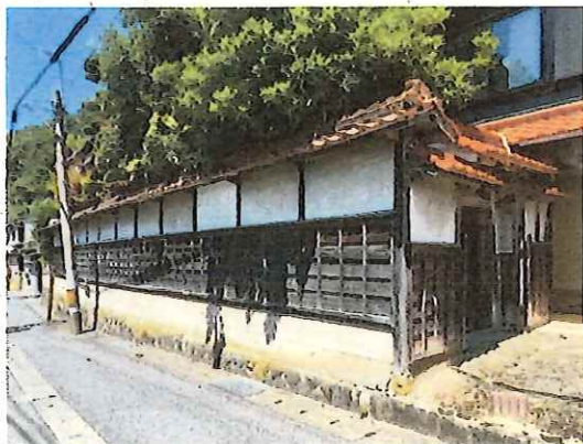
庭門及び塀・全 景
