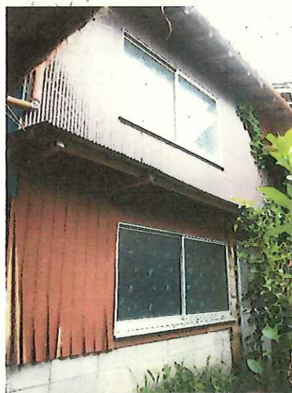
物置小屋兼宿泊棟・全 景
