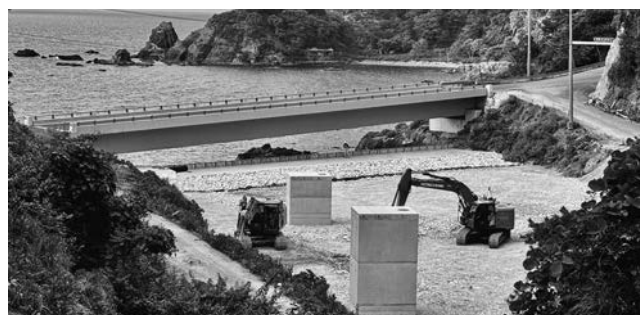
釜屋橋工事の埋め立ての様子
