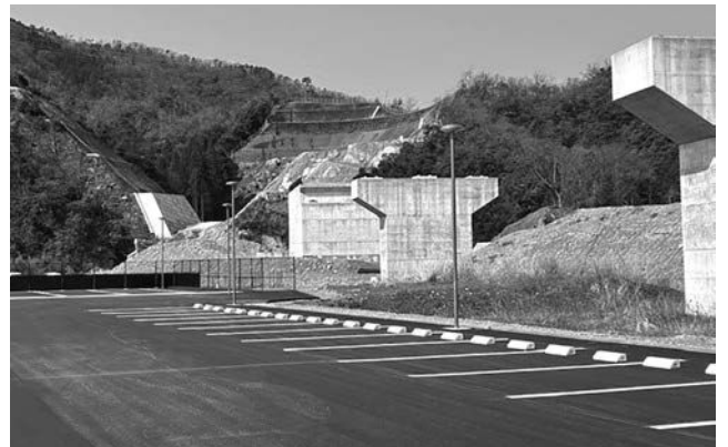
開通が待たれる山陰近畿自動車道、浜坂〜鳥取間
