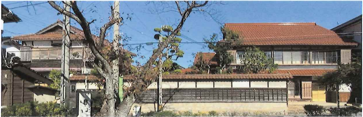
「廻船問屋千原屋道盛邸」整備事業・象施設全景写真（南から北を望む）
