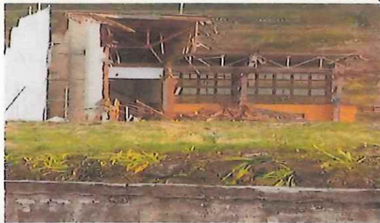
解体工事中の体育館
