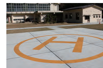
八田防災広場完成
