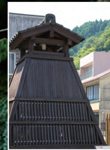
常夜灯風の建物から湯煙が立ち上る。温泉街らしい演出。
