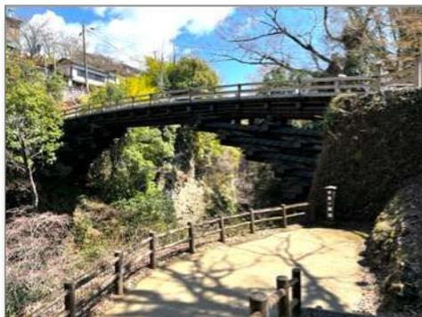
甲府を後に大月市にある猿橋に向かいました。「甲斐の猿橋」は、「岩国の錦帯橋」「木曾の棧（かけはし）」と並び日本三奇橋のひとつです。長さ31m、幅3.3mのさして大きくない木橋ですが谷が31mと深く、橋脚がたてられないため、橋脚を使わずに両岸から張り出した四層のはね木によって橋を支えています。橋の歴史は奈良時代に遡ると伝えられています。なお、猿橋が架けられている桂川は山中湖に源を発し、神奈川県に入ると相模川と呼ばれ、相模湾に注ぎます。
