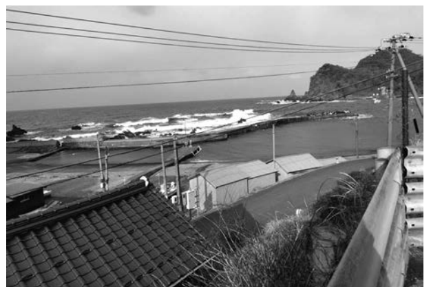
工事中の釜屋漁港
