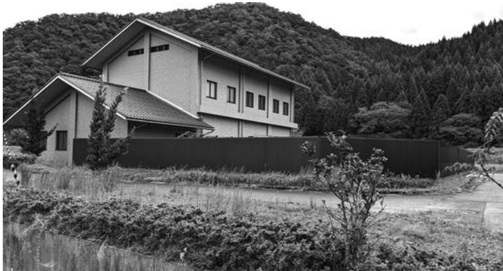
新温泉町井土にある下水処理場
