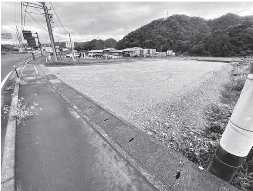
拡張された道の駅駐車場
