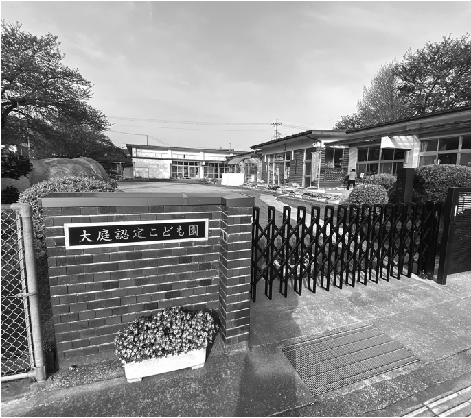
昭和49年建設（築50年）の大庭認定こども園。耐震補強・改修工事により約20年の長寿命化が図られることとなった
