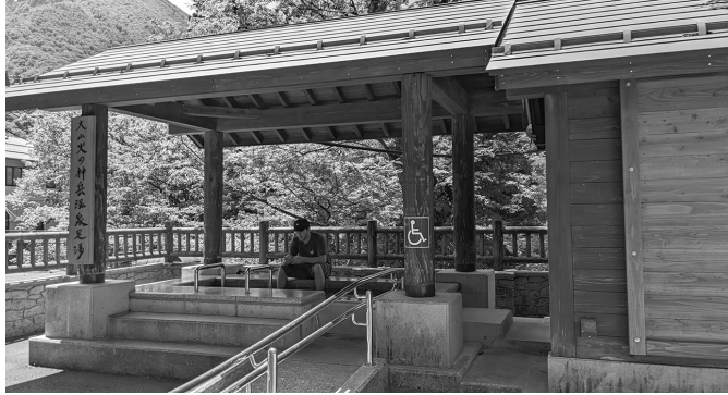
車イスのまま利用できる大山町の足湯。スロープ、手すりも付いている
