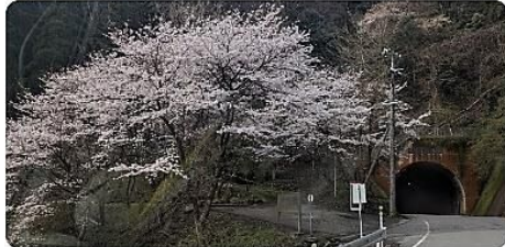
三尾トンネル
