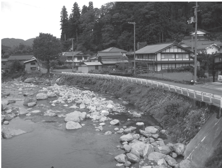
開設以来初の冠水が発生した岸田橋下流の右岸道路。今後に備えた冠水対策が必要
