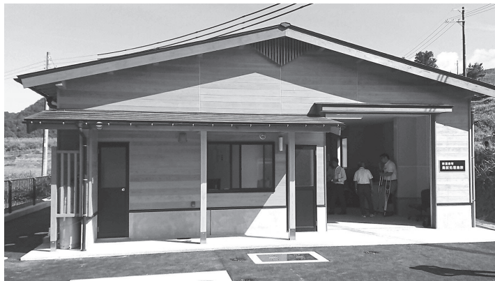
解体処理に向けて臨機応変に対応できる施設運営に期待する
