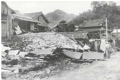
倒壊した魚類加工納屋（諸寄） 昭和 36 年（1961）第 2 室戸台風
