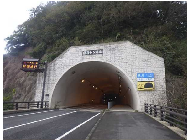
塩谷トンネル（13歳） 健全の診断判定区分Ⅱ
