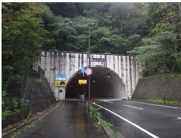
城山トンネル（13歳） 健全の診断判定区分Ⅱ
