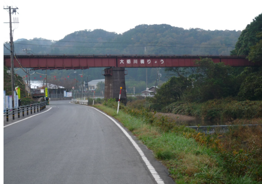
JR 大栃川橋りょう 鉄橋
