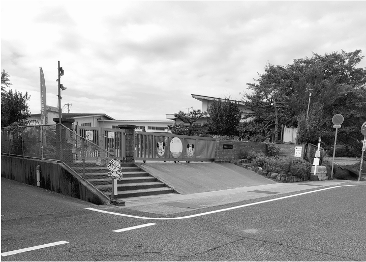
浜坂下水処理施設は耐水化を進めているのに、浜坂認定こども園は、早期対応、早期避難で安全確保が出来るのか
