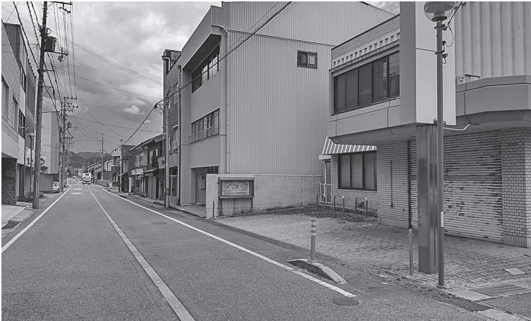
文化財収蔵庫として改修される旧みなと銀行
