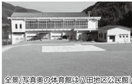
防災資機材保管施設
