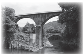
▲深い谷を繋ぐ橋
