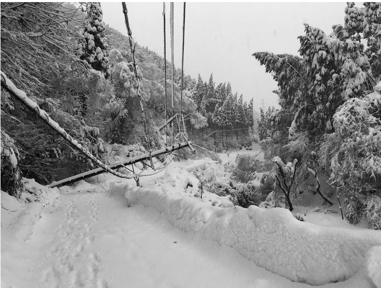
倒木により引っ張られて傾いた電柱（町道金屋高山線）
