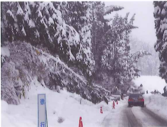
湿った雪による倒木の被害(県道)
