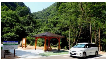
入口に新しく東屋も完成
