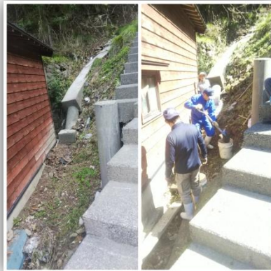
バケツリレーで土砂撤去
