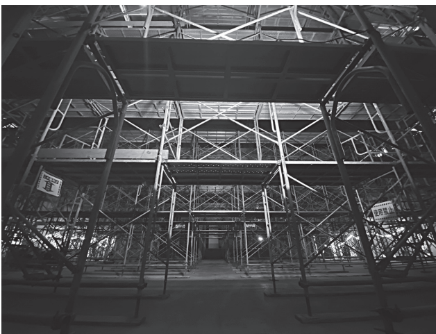
改修作業が続く夢ホール内部
