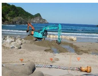
で、海開きが始まるまでには完成するようです。工事内容は、海岸に2か所の砂防堤がありますが、これは砂の浸食を防ぐもので、今では、一部沈んでしまい用をなしていないということで、捨て石を下にひきかさ上げるものです。工事は、香美町の株式会社伊藤組が受注しています。
