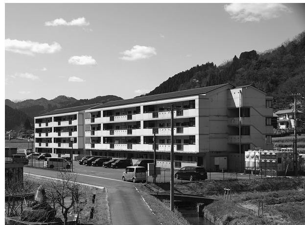
町営住宅と特定公共賃貸住宅がある井土団地
