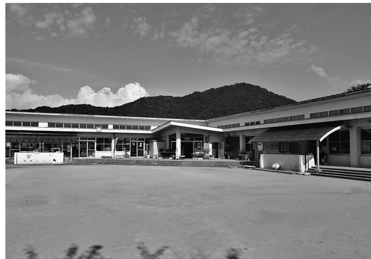
危険建物と判定された園舎の整備が急がれる。
