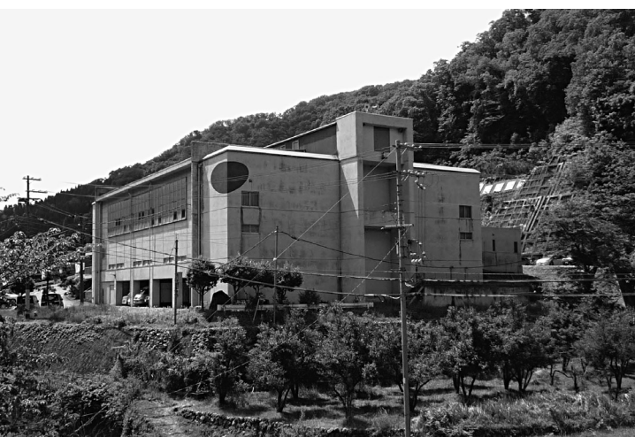
計画どおりの完成が望まれる夢ホール耐震改修
