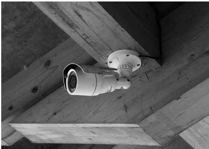
まだまだ少ない防犯カメラ、町は率先して設置すべきだ。
