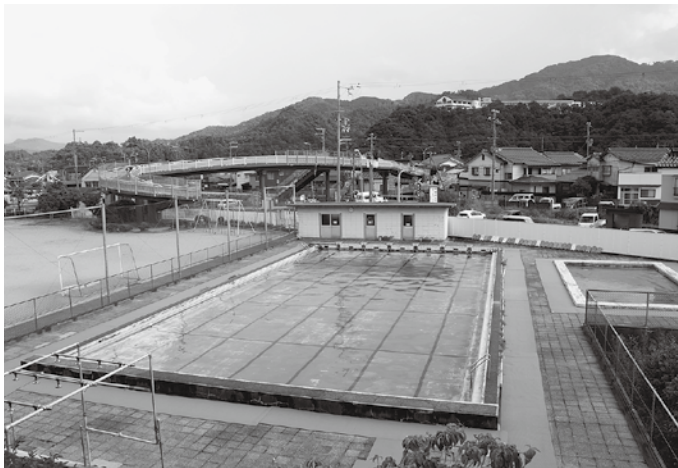
道路改良工事に伴い、浜坂北小学校プールは移転。歩道橋は撤去される。
