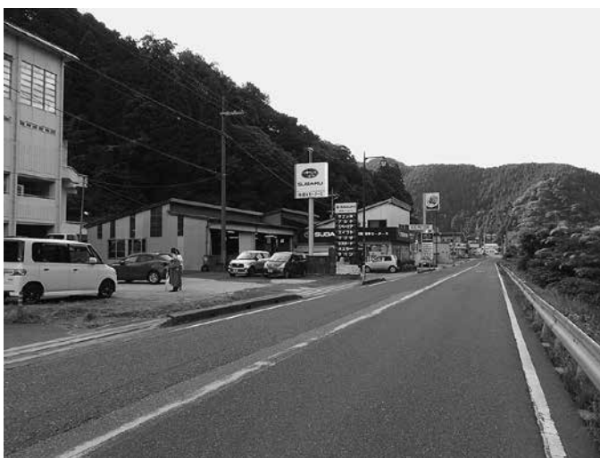
歩行者の安全確保のため、歩道の改修が急がれる。
