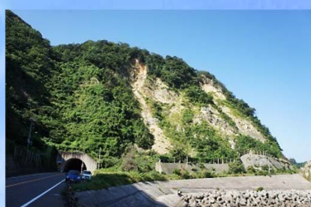
B 穴見の大崩れ 平成2年の台風19号で山肌が大きく崩落 現在はトンネルで抜けてますが、旧国道 を飲み込みました
