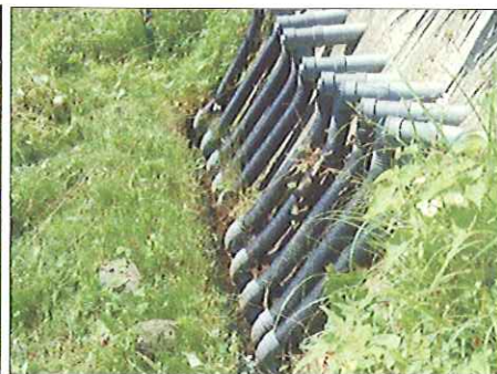
水抜きボーリング工
