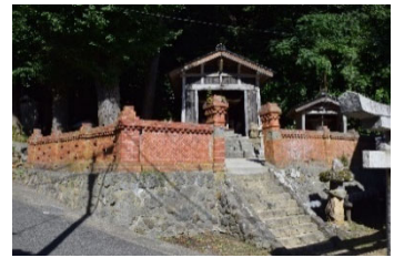
釜屋三柱神社の煉瓦堀
