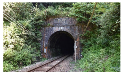
桃観トンネル
