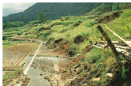
斜面崩壊（石橋） 平成2年（1990）台風19号
