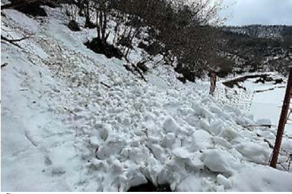
雪崩でシカ柵が倒壊(2月8日)
