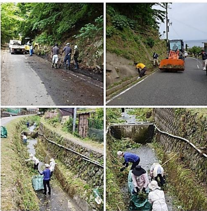
重機を使い溝の土砂撤去作業
