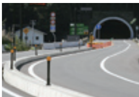
東浜居組道路（七坂トンネル）
