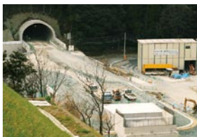
東浜居組道路（七坂トンネル）
