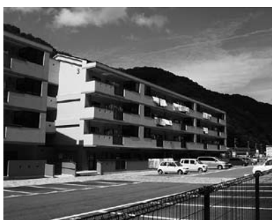
▲町営住宅井土団地
