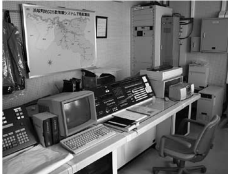
▲老朽化が進んでいる防災行政無線 (新温泉町役場・無線室)
