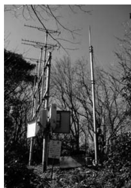
▲老朽化した共聴アンテナ
