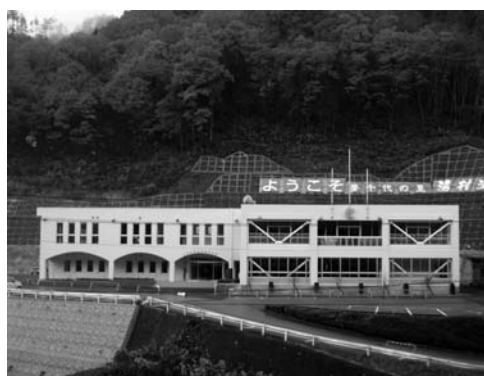
完成した新・温泉総合支所
